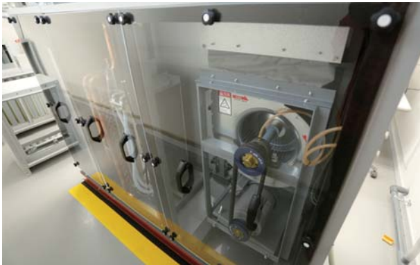
外調機の外面をアクリル板で加工しているの で、普段は見えない内部構造の理解につながります。
