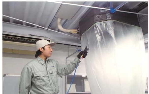
PAC室内機洗浄研修
